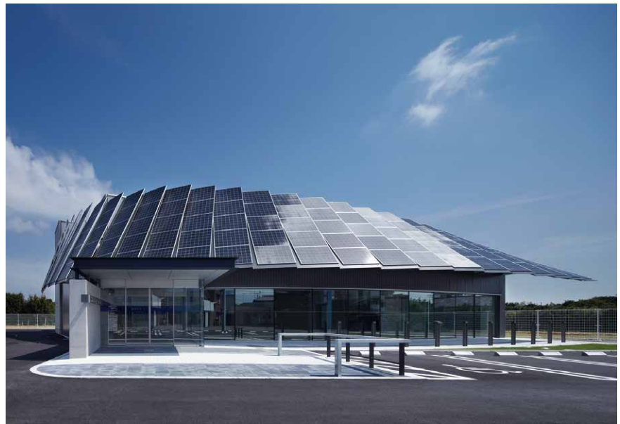
地元の金融機関「浜松信用金庫」様の施工例。斬新な外觀デザイン以上に、信用金庫としての機能を考慮・集約したことが誇りだ。
